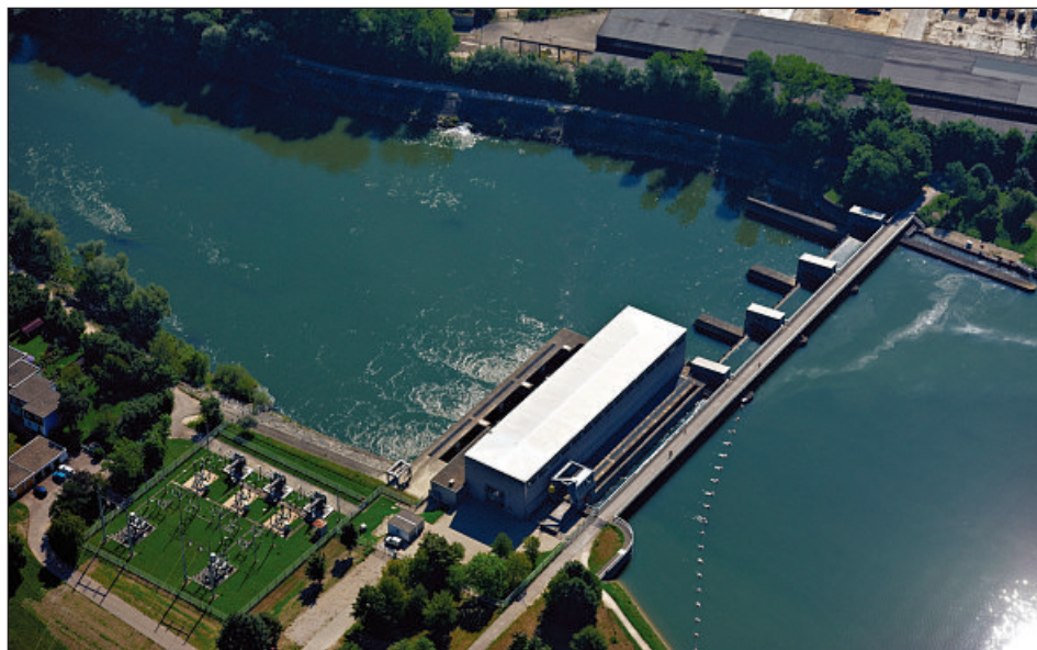
Das Donaukraftwerk Ingolstadt liefert Strom für die Deutsche Bahn (16 2/3 Hertz). Derzeit erhält es ein Umgebungsgewässer für den Fischeaufstieg.
