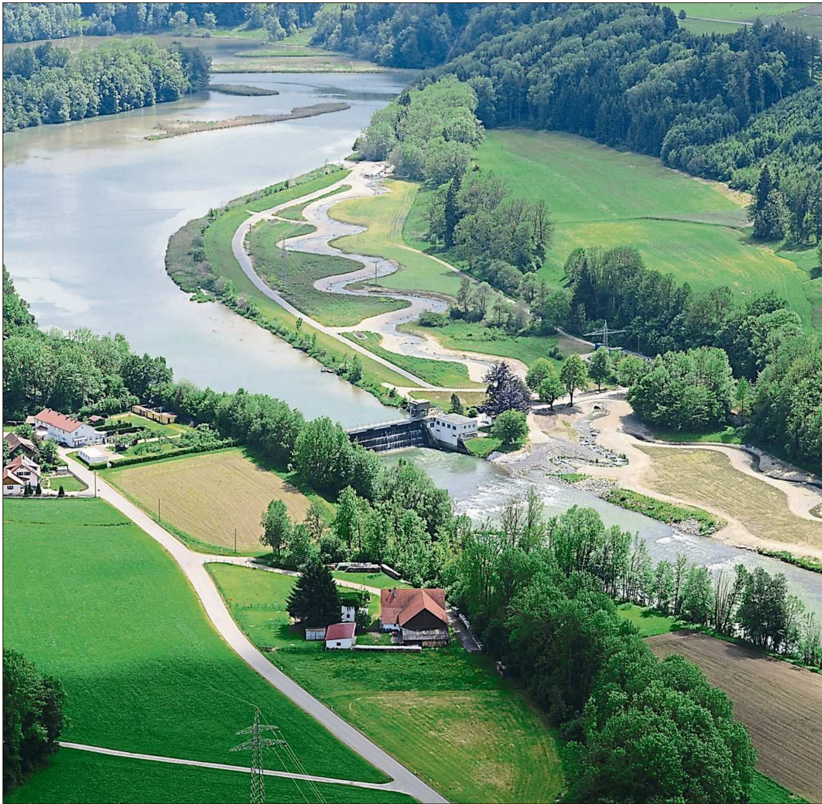
Ein naturnahes Umgebungsgewässer und neuen Lebensraum für Tiere und Pflanzen bietet das Kraftwerk Maria Steinbach an der Iller.
